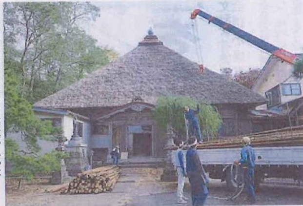
解体作業が始まった松源寺。かやぶきの本堂は県内でも珍しいといふ
