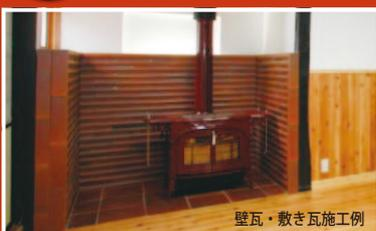
壁瓦・敷き瓦施工例
