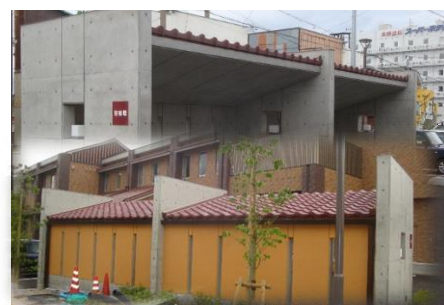
駐輪場屋根 (石州瓦／釉薬特注色) (株)木村窯業所
