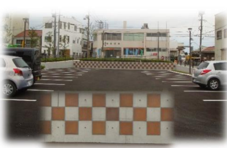
駐車場壁面 (タイル 300mm／無釉窯変) (株)木村窯業所
